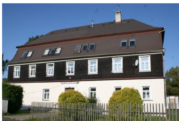
Výměna oken v č.p.K2 (foto A.Macháčková)
