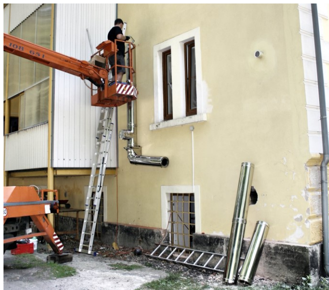
Výměna kotlů v č.p.371 (foto R.Pavlík)
