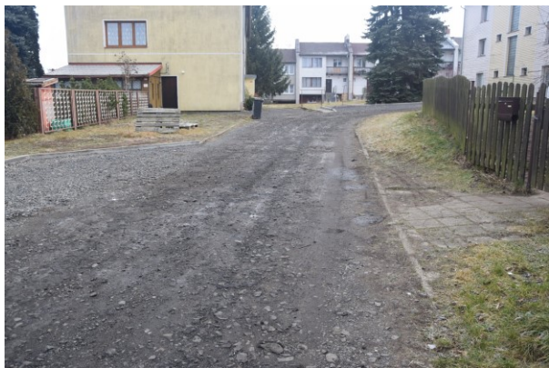
Komunikace k č.p.469 před rekonstrukcí (foto A.Macháčková)
