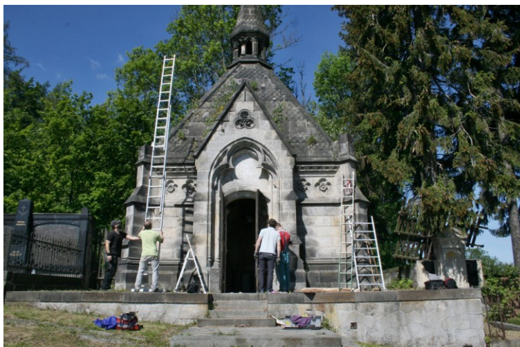
Oprava hrobky rodiny Brass (foto R.Pavlík)
