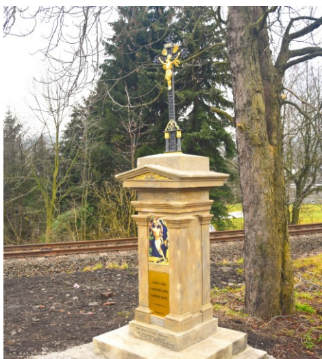
Oprava křížků směr Studánka (foto R.Pavlík)
