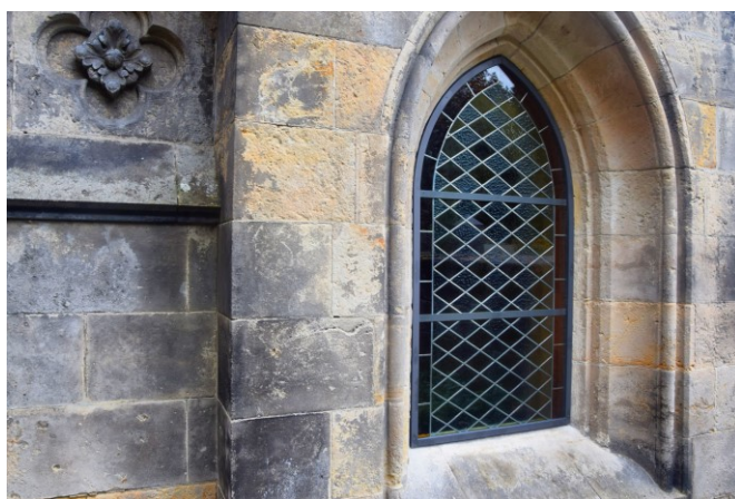
Nová vitrážová okna v hrobce Brass (foto R.Pavlík)
