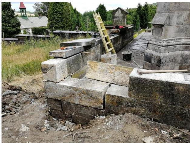
Oprava brassovy hrobky - usazení vstupního schodiště a očištění kamenné terasy (foto: Obec Dolní Podluží)
