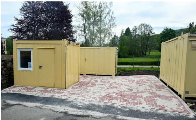
Instalace nových kontejnerů ve sběrovém dvoře (foto A.Macháčková)
