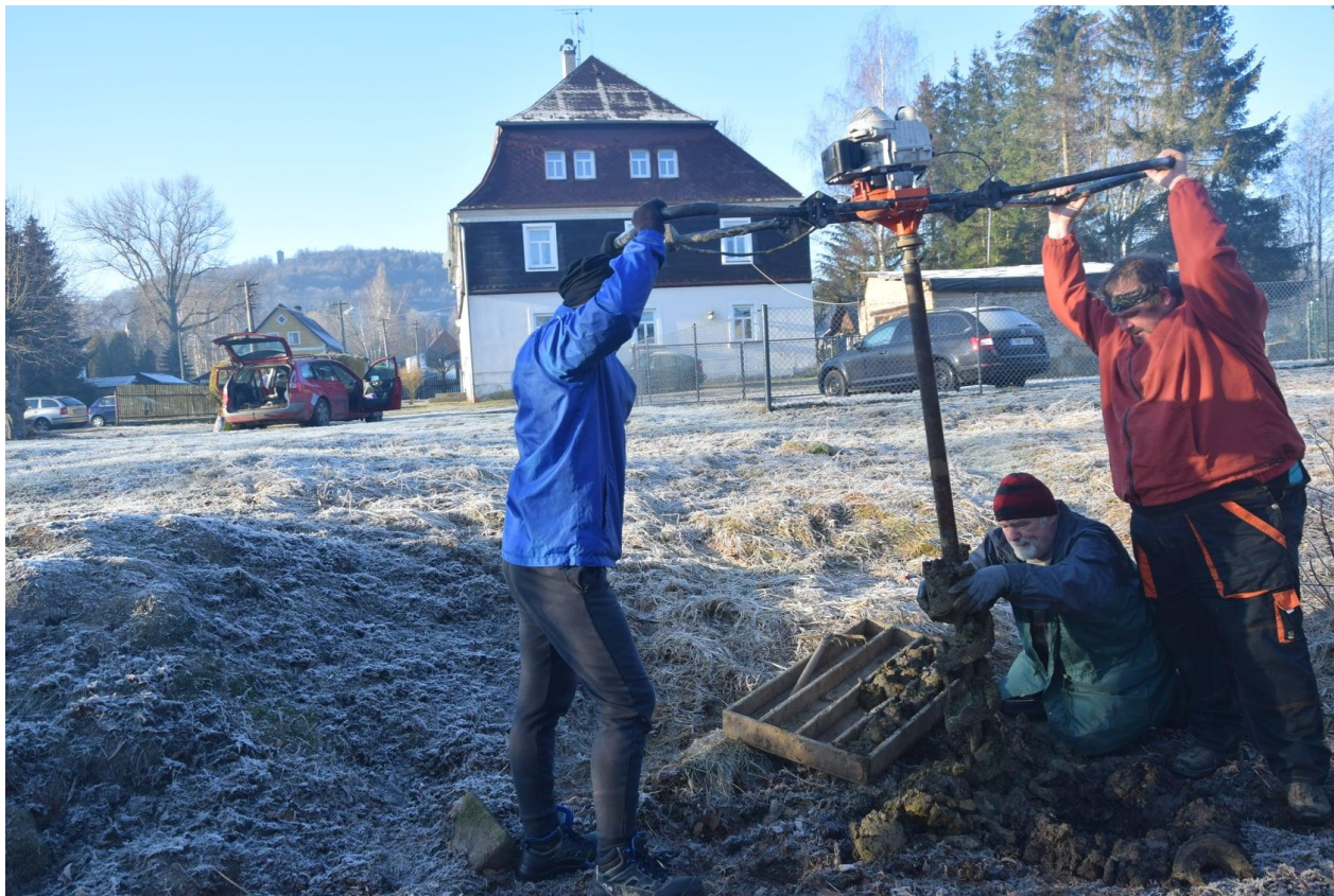
Hydrogeologická sonda u domu Kateřina 2 (foto L.Janků)
