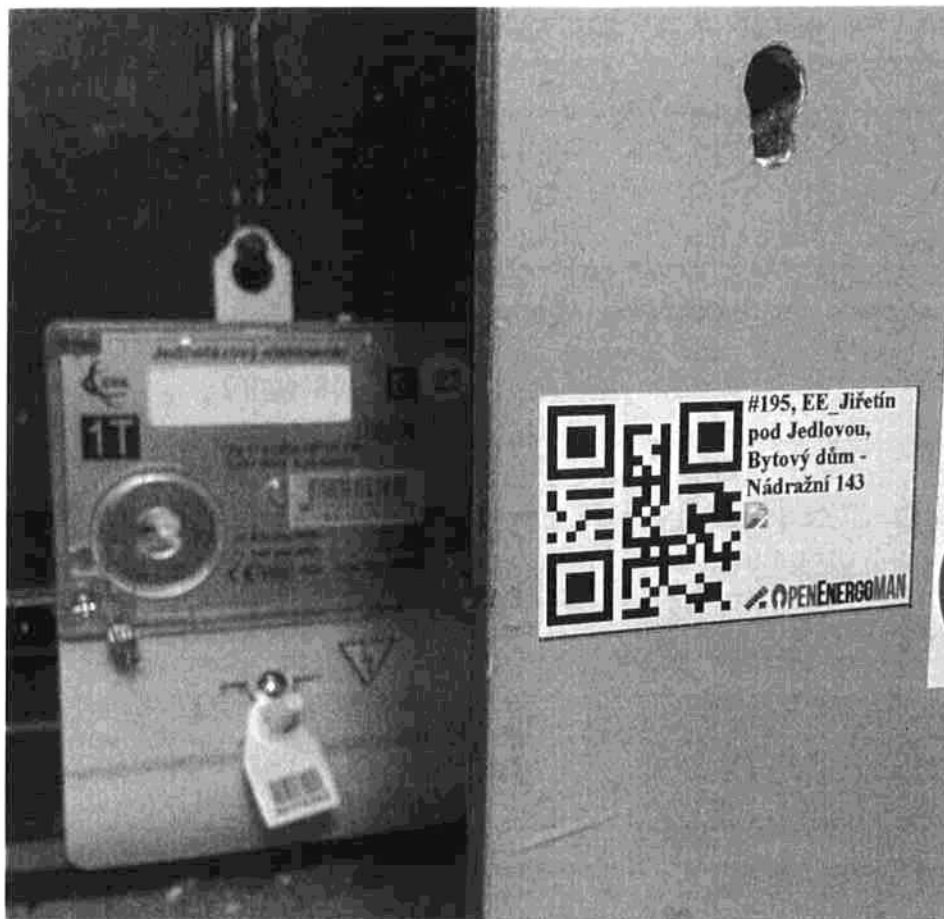
Příklad umístění QR kódu pro realizaci samoodečtů pomocí mobilního telefonu.
