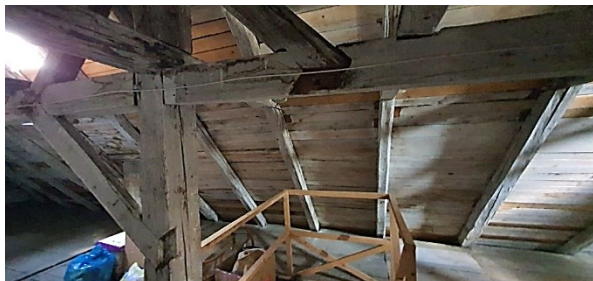
Obrázek 9, 10 – Pohled na chybějící dřevěný pásek mezi podvrcholovou vaznicí a sloupkem v místě nad výlezem na půdu
