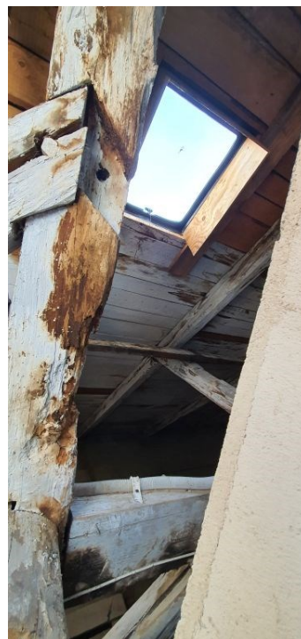
Obrázek 13, 14, 15 – Pohled na oslabenou stávající dřevěnou podvrcholovou vaznici a stávající dřevěný sloupek u pravého komína
