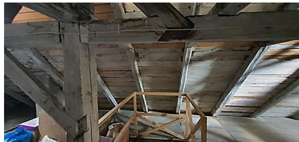
Obrázek 9, 10 – Pohled na chybějící dřevěný pásek mezi podvrcholovou vaznicí a sloupkem v místě nad výlezem na půdu
