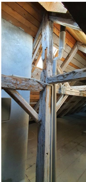
Obrázek 13, 14, 15 – Pohled na oslabenou stávající dřevěnou podvrcholovou vaznici a stávající dřevěný sloupek u pravého komína
