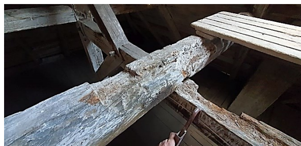
Obrázek 11, 12 – Pohled na oslabenou stávající dřevěnou podvrcholovou vaznici a stávající dřevěný hambálek u levého komína
