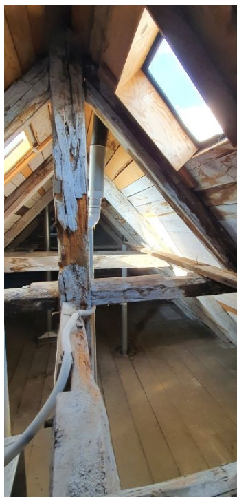
Obrázek 13, 14, 15 – Pohled na oslabenou stávající dřevěnou podvrcholovou vaznici a stávající dřevěný sloupek u pravého komína
