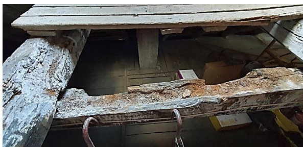
Obrázek 11, 12 – Pohled na oslabenou stávající dřevěnou podvrcholovou vaznici a stávající dřevěný hambálek u levého komína
