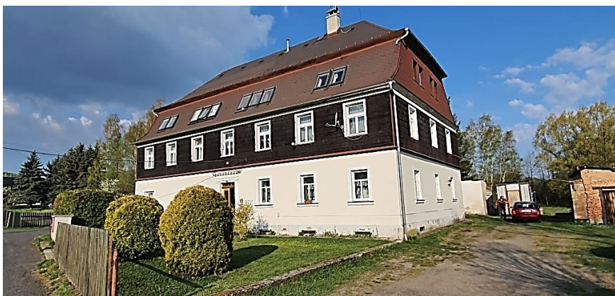
Obrázek 2 – Pohled na stávající objekt č.p. 2 v obci Dolní Podluží – Kateřina na p.č. st. 27/1 v k.ú. Dolní Podluží od východu
