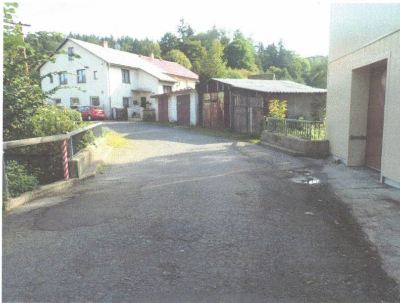
Celkový pohled na most z pravobřežního předpolí
