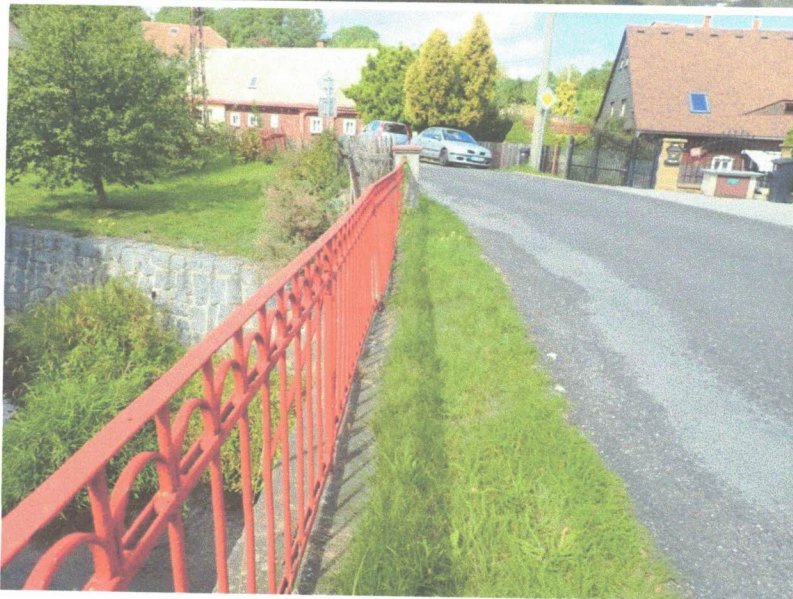
Pohled na římsu a zábradlí na vtoku
