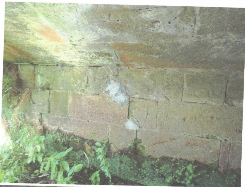
Pohled na levobřežní opěru na vtoku
