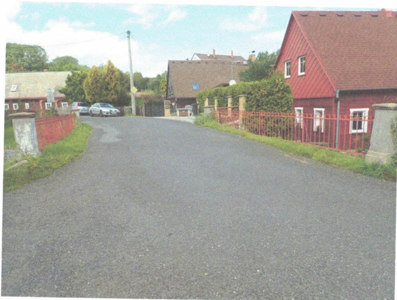
Celkový pohled na most z pravobřežního předpolí
