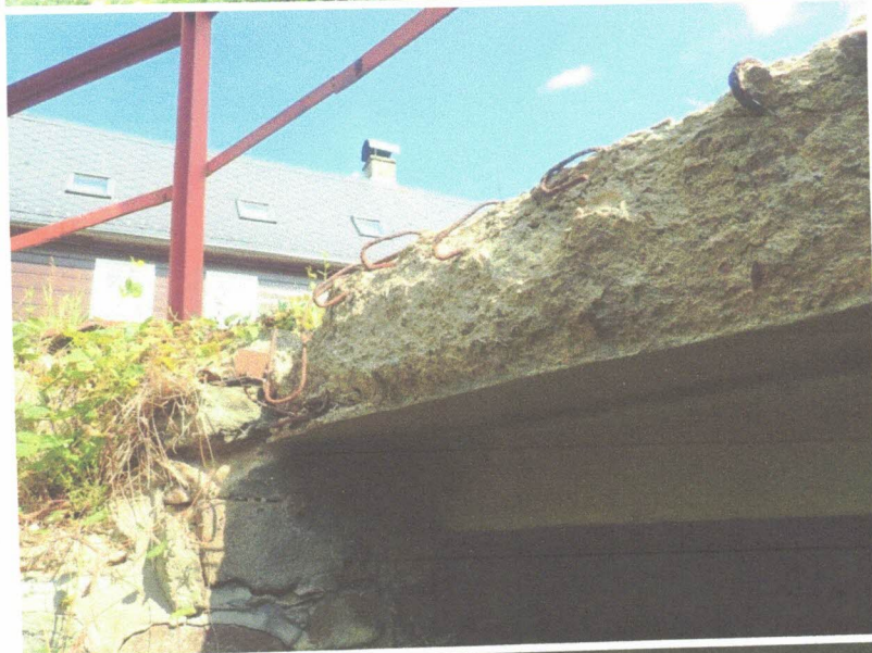
Římka na vtoku
