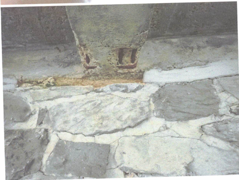
Uložení na opěře
