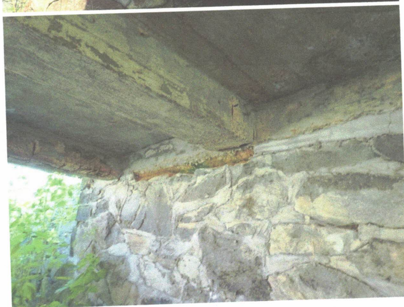
Podhled trámů v uložení u levobřežní opěry
