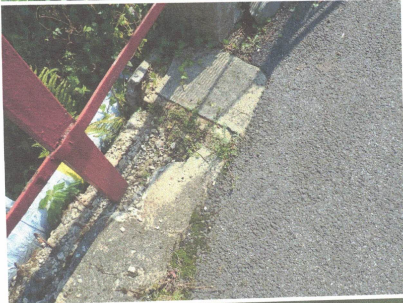
Římsa na výtoku před pravobřežní opěrou
