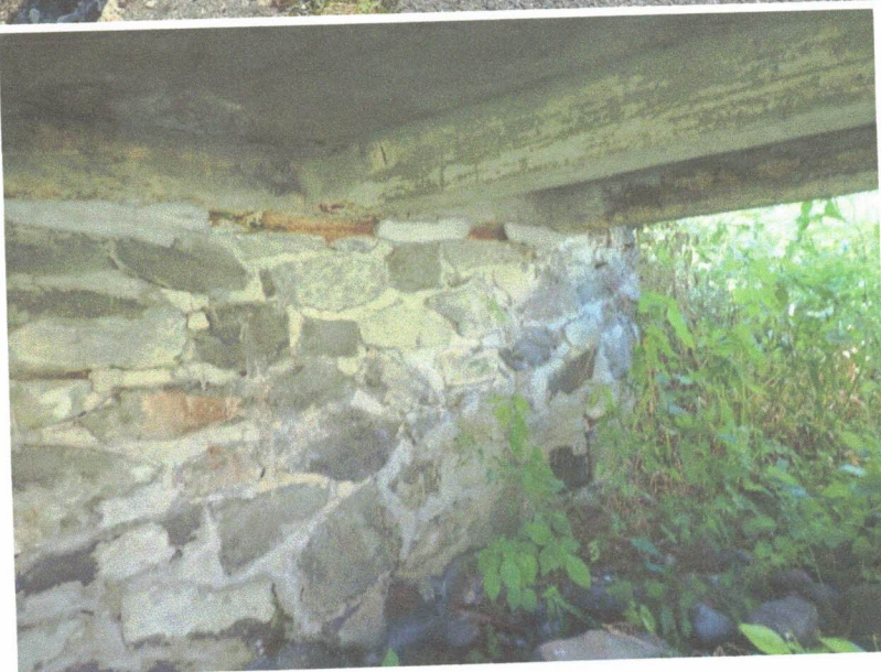
Pohled pravobřežní opěru
