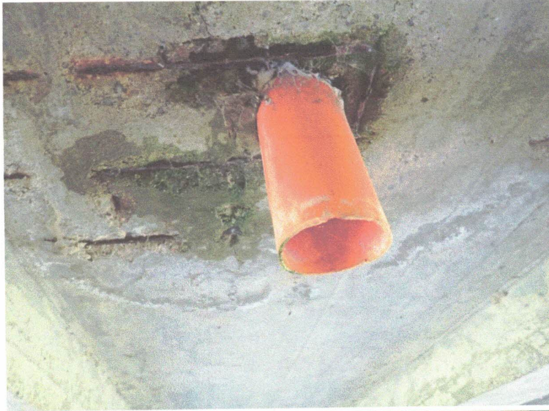
Podhled desky v místě odvodnění
