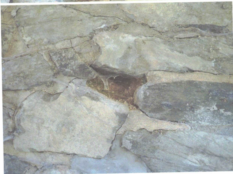
Chybějící kameny ve zdivu pravobřežní opěry
