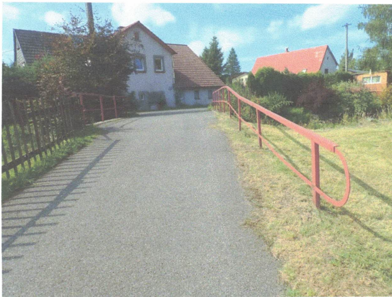
Celkový pohled na most z levobřežního předpolí
