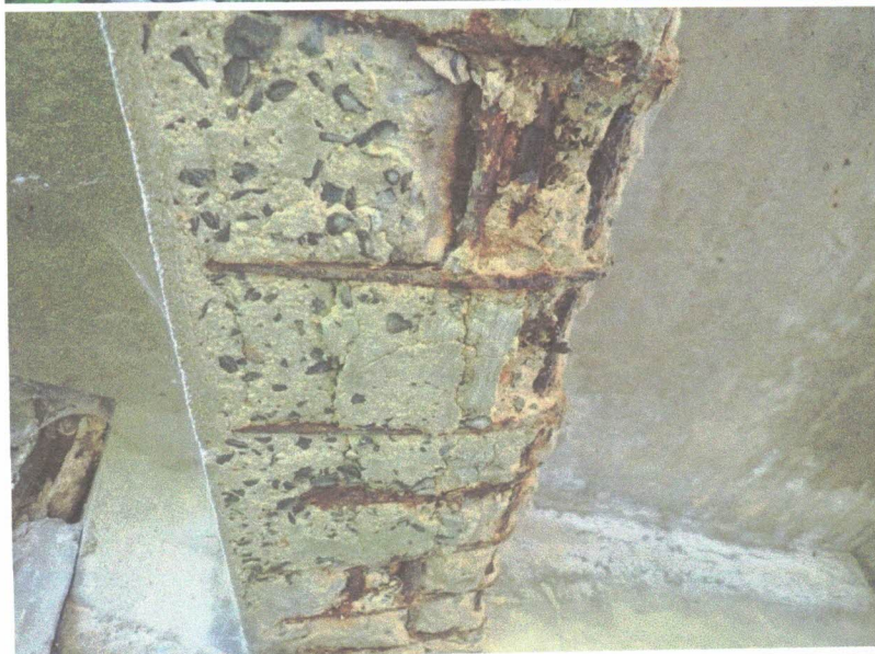
Podhled krajního trámu na výtoku u pravobřežní opěry
