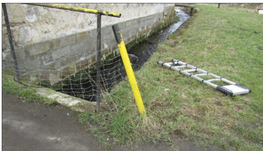
Pohled na pravé zábradlí (ve směru staničení)
