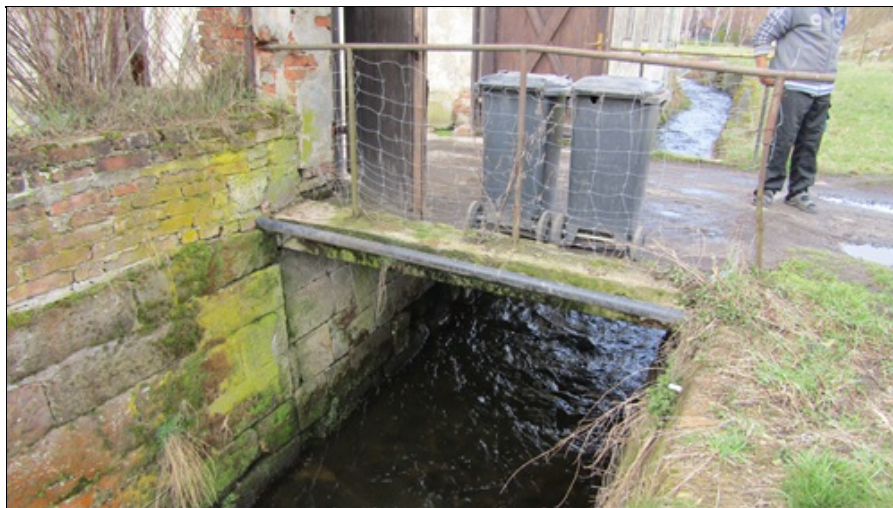
Pohled zleva (chránička IS) - deformace horního madla
