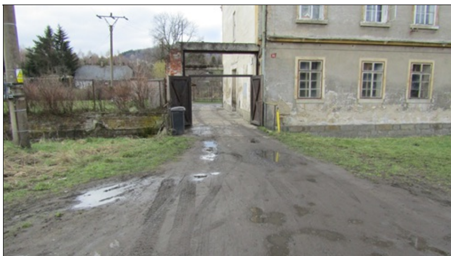
Pohled ve směru staničení
