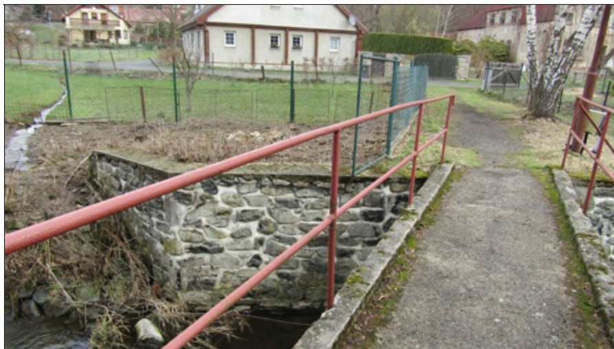
Pohled na pravé zábradlí (proti směru staničení)
